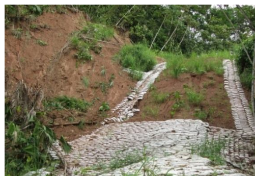
Aguaytía Energy: Vista de obras de control de erosión concluidas en KP 1+800 del flowline de 4" del pozo 6AG. Mayo 2011.
