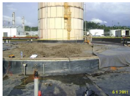
PLANTA MALVINAS: Vista de cama de arena y la inspección de los ánodos de la protección catódica. Enero 2011.
