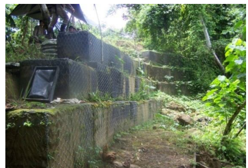
Pluspetrol (Pagoreni): Vista de trabajos de estabilización de taludes. Abril 2011.
