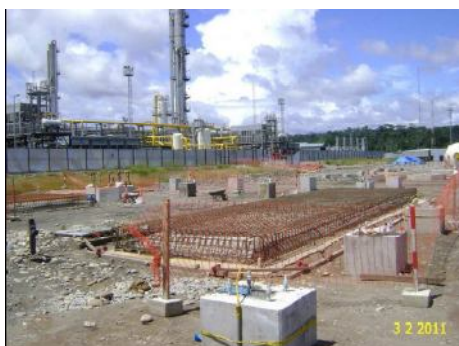
PLANTA MALVINAS: Vista muestra los trabajos de encofrado y armado para próximo vaciado de concreto en los cimientos en los futuros turbo compresores de los productos de tope de la estabilizadora CAY-22200 así como de otros equipos del área de estabilización. Enero 2011.
