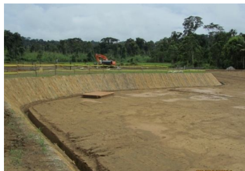
PLUSPETROL (Pagoreni): Vista de zona de maniobras de grúa para su embarque y desembarque. (Se aprecia los canales para descarga del agua de escorrentía). Mayo 2011.
