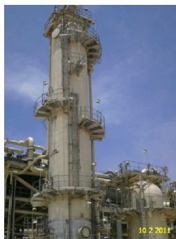
PLANTA PAMPA MELCHORITA: Vista de Columna C-1101 AGR Absorber. Cuenta con su placa de fabricación y de certificación. Este recipiente a presión, al igual que todos los recipientes a presión no aislados existentes en la Planta, fue sometido a una inspección visual así como medición ultrasonido de espesores. Febrero 2011.
