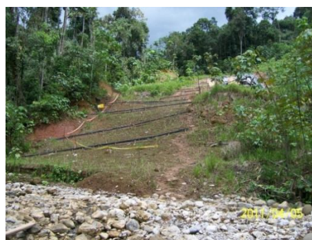
Pluspetrol (Cashiriari): Vista de trabajadores para la estabilización de taludes. Abril 2011.
