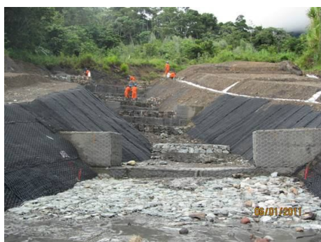
TGP: Vista de re conformación del canal lateral en el KP 184+900. Enero 2011.
