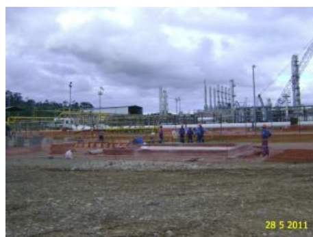
PLANTA MALVINAS: Vista de área 310, donde será reubicado el Scraper. Se observa trabajos de construcción de bases de concreto para el soporte de las tuberías. Mayo 2011.
