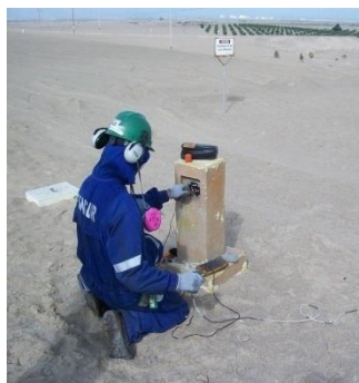
EGESUR: Instantes de toma de potencial en poste N° 3 del sistema de protección catódica del ducto de gas natural de Minsur S.A. Febrero 2011
