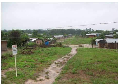
Aguaytía Energy: Vista del Kp. 4+750 donde se aprecia las estacas en los márgenes laterales del Derecho de Vía. Marzo 2011.
