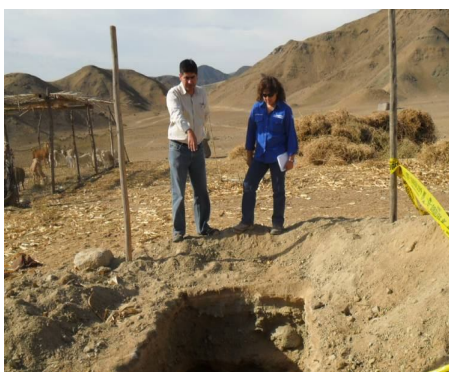
Perú LNG: Vista de la construcción de 16 letrinas de las 18 que se han planificado realizar como compromiso asumido por PLNG. Marzo 2011.
