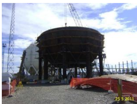
PLANTA MALVINAS: Vista panorámica que muestra el estado actual del avance de la construcción del tanque esférico en el Area 380. El tanque en construcción alcanza la línea ecuatorial y se está procediendo a soldar todas las juntas tanto verticales como horizontales. Mayo 2011
