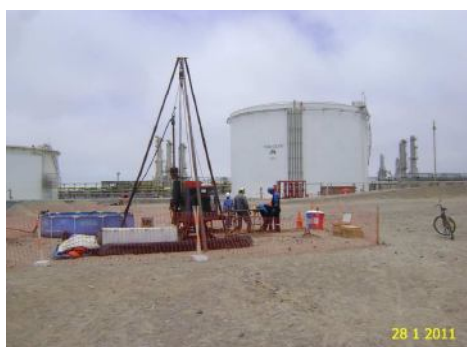
PLANTA PISCO: Vista del castillo de perforación que está realizado el sondeo hasta 30 metros de profundidad del suelo donde será construido el nuevo tanque de Diesel-2. Enero 2011.
