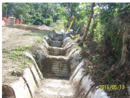
TGP: Limpieza y reconformación de Canales. (KP-91+020). Mayo 2011.
