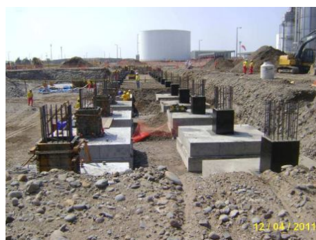
PLANTA PISCO: Vista general de la construcción de los cimientos del pipe rack o parral en la zona 1-1ª, en el Área 520 del Proyecto. Se observa las zapatas ya construidas así como los pedestales parcialmente. Abril 2011.
