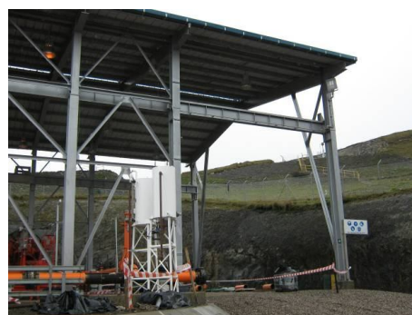
TGP: Vista de los trabajos finales del techo de la cuarta bomba en la PS4. Febrero 2011.
