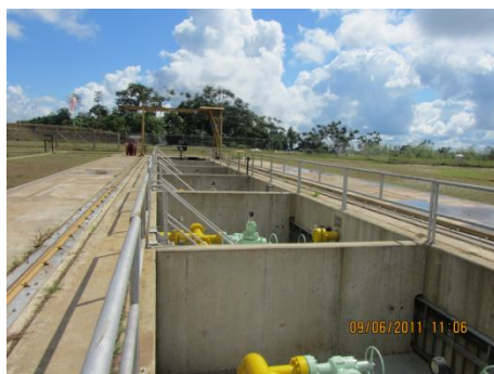
Plataforma Cashiriari 1. Vista de área de cellars. Junio 2011.
