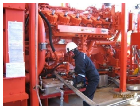
TGP: Vista del trabajo de alineamiento del motor con la caja incrementadora - PS4. Junio 2011.
