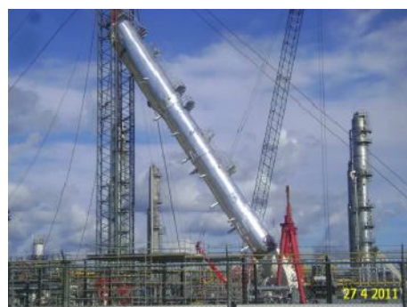
PLANTA MALVINAS: Vista lateral de los pórticos principal y de retenida, observándose a la torre deetanizadora ya en posición de aproximadamente 60°. Abril 2011.
