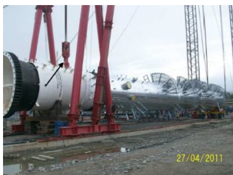
PLANTA MALVINAS: vista muestra a la Torre Deetanizadora CBA-22220 aún en posición horizontal sobre sus soportes temporales. Abril 2011
