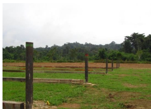
PLUSPETROL (Pagoreni): Vista de pipe racks donde se instalarán los tubos. Junio 2011.
