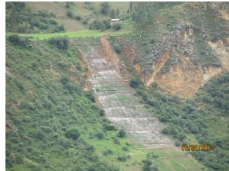
Perú LNG: Obras geotécnicas en el tramo KP 31+750 al KP 31+600. Febrero 2011.
