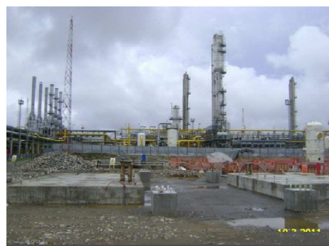
PLANTA MALVINAS: Vista de cimientos ya terminados para equipamiento en el Área 340 del Proyecto. Se muestra los cimientos para los dos nuevos compresores de los gases de tope de la nueva columna estabilizadora. Marzo 2011.
