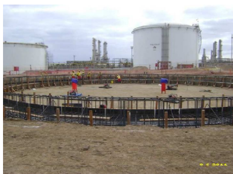
PLANTA PISCO: Vista general del encofrado circular para la construcción de la zapata para el futuro tanque de diesel TKBJ-23000. En la parte central interior del cimiento en construcción se ha compactado material granular estructural. Junio 2011.
