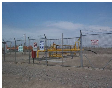
Pluspetrol: Vista de la trampa de Scraper de lanzamiento de Humay. Febrero 2011.
