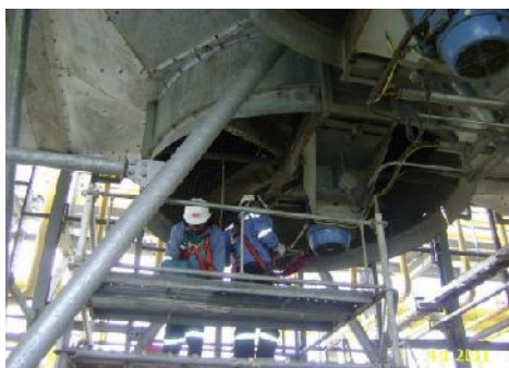
PLANTA MALVINAS: Vista que muestra a personal de la contratista Wood Group en labores de mantenimiento preventivo de los aerorefrigerantes EAL 25140-C2 y EAL-25140-C3 correspondientes a la segunda etapa de compresión del Turbo Compresor NP N° 5. Enero 2011.
