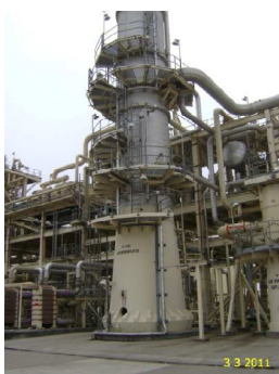
Perú LNG: Vista de la columna C-1102 AGR Regenerator, la misma que fue objeto de una inspección visual externa, para verificar el buen estado del aislamiento, las bridas así como la instrumentación local existente. . Marzo 2011.
