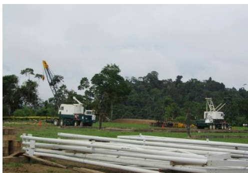
PLUSPETROL (Pagoreni): Vista de las dos grúas de 40 y 90 toneladas en espera de la llegada de la tubería. Junio 2011.
