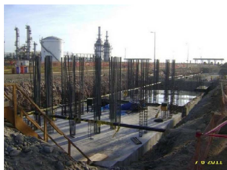
PLANTA PISCO: Vista de área que corresponde a los Hornos nuevos MAP-25010 y MAP-35010. Ya cuenta con zapatas de cimientos faltando el encofrado de los fustes o columnas de los hornos. Junio 2011.
