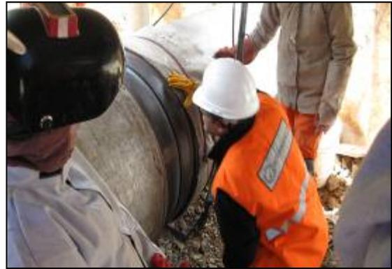
**KP 24:** Consultora Interinspect realiza inspección visual de junta 77, resultando ésta conforme.
