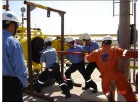
**PLANTA PISCO:** Colocación del Pig hasta la zona de estrangulamiento, antes del ingreso del combustible para desplazarlo por diferencial mínima de presión.
