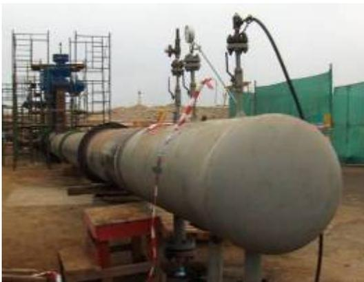
**Obrador San Clemente:** Prueba Hidrostática de válvulas GOV 5037 y GOV 5038.
