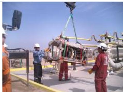
**PLANTA PISCO:** Desmontaje del Pig Georeferencial antes del pase por la línea de Nafta
