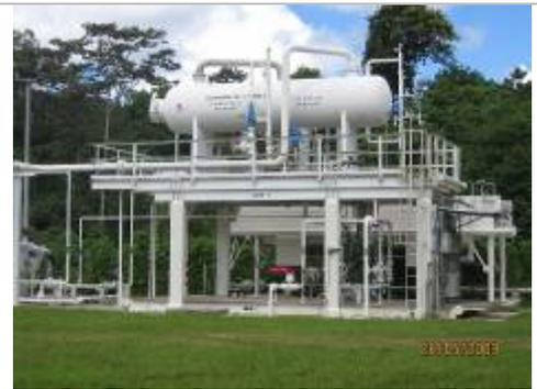
**AGUAYTIA ENERGY:** Separador de gas y líquidos en la Planta de Separación de Gas de Curimaná.
