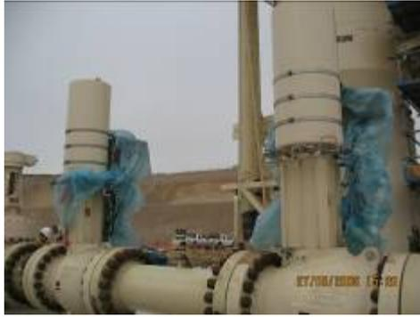
**PLANTA MELCHORITA:** Entrada de Gas - Válvulas de Bloqueo del Sistema HIPS
