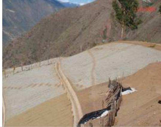
**KP 42+700:** Recomposición del Derecho de Vía, aplicación de geomantas y construcción de un sistema de drenaje superficial.
