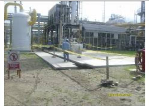
**PLANTA MALVINAS:** Área delimitada y señalizada durante trabajos de instalación de losas de concreto en criogénica 1 y 2
