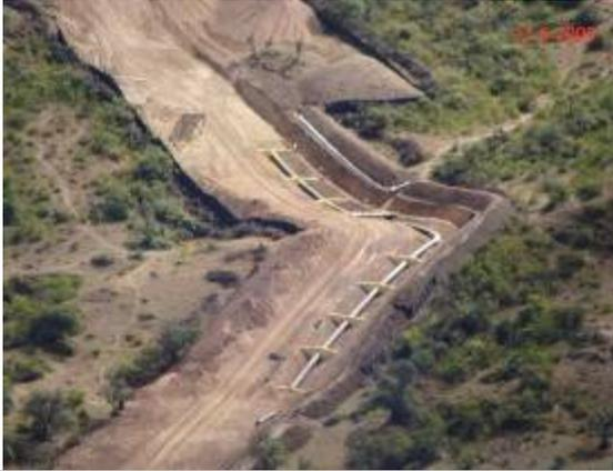
**KP 31+300:** Instalación de barreras en zanja (Ditch Bracker).
