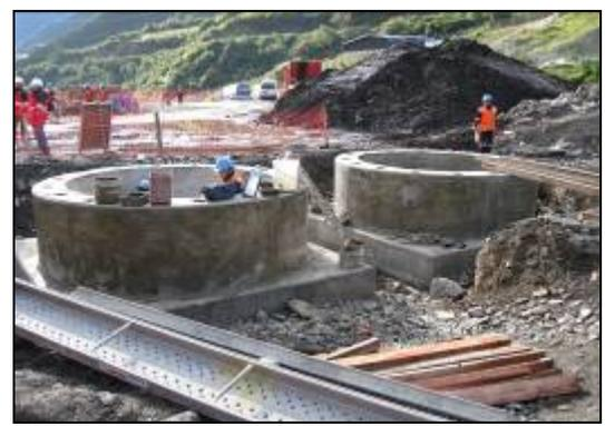
Construcción de las bases de concreto de tanques acumuladores de aire comprimido.
