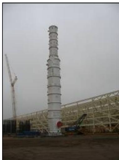
Intercambiador principal de calor y instalado. Aquí se obtendrá el GNL
