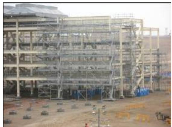
Perú LNG – Estructura metálicas del Área de Procesos que servirá para soporte de tuberías y de aero refrigerantes. Obsérvese los aero refrigerantes instalados en la parte superior
