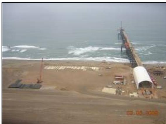
Perú LNG- Se han instalado 33 hileras de pilotes en el puente de caballetes
