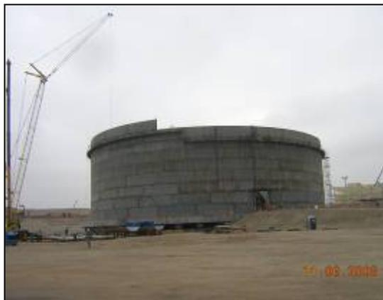
Tanque 3401 - Prosiguen los trabajos de soldadura del noveno anillo
