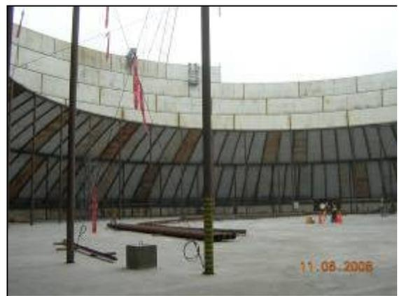
Tanque 3401. Vista interior del tanque donde se está construyendo el techo tipo domo.
