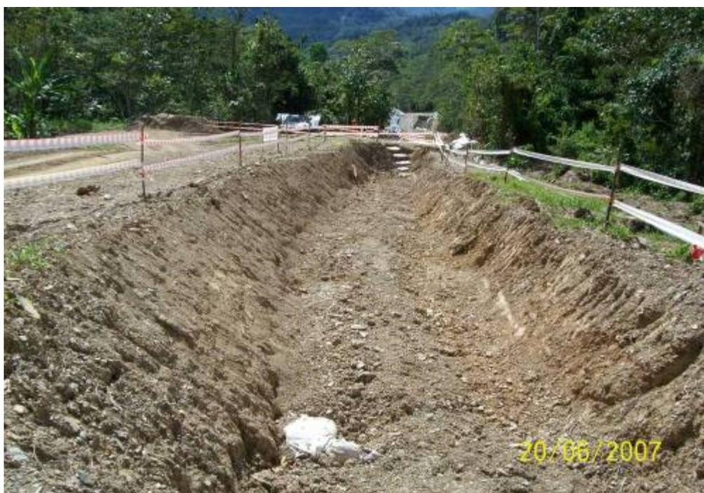
**Foto 8.** KP 125+650 DDV, descarga de material sobre el ducto LGN de 14 pulgadas (alivio de tensiones).
