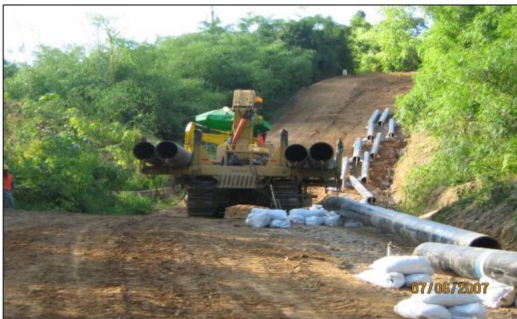
**Foto 22.** Vista panorámica del DdV durante el desfile de tuberías a la altura del PK 12+500.
