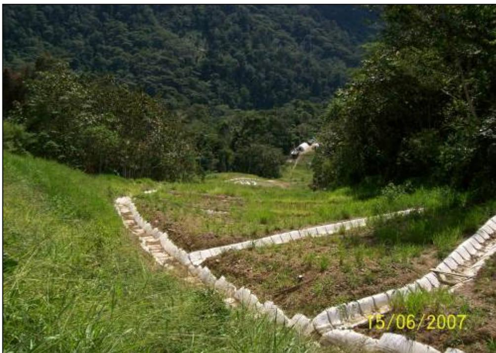
**Foto 2.** KP 95+300 DDV, detalle de los trabajos geotécnicos superficiales que se encontraron en buen estado en la progresiva indicada.
