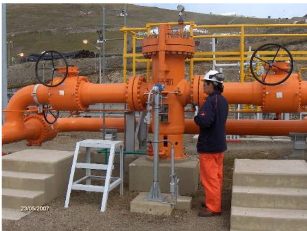
**Foto 9.** Verificando presión diferencial de filtro Gora de LGN en PS-4
