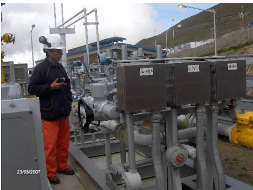
**Foto 10.** Verificando parámetros de operación en skid de medición de Gas Natural en PS-4
