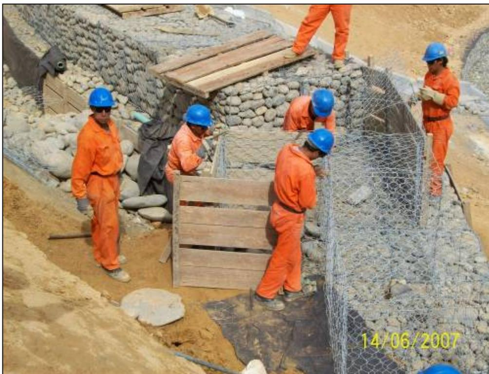
**Foto 5.** KP 108+150, detalle de la construcción de gaviones -personal de Geotecnia (80 personas trabajan en la obra).
