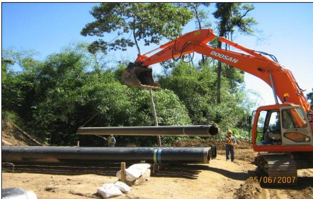
**Foto 21.** Vista panorámica de la maquinaria y trabajos que se realizan en el DdV (acopio de tuberías en la línea).
