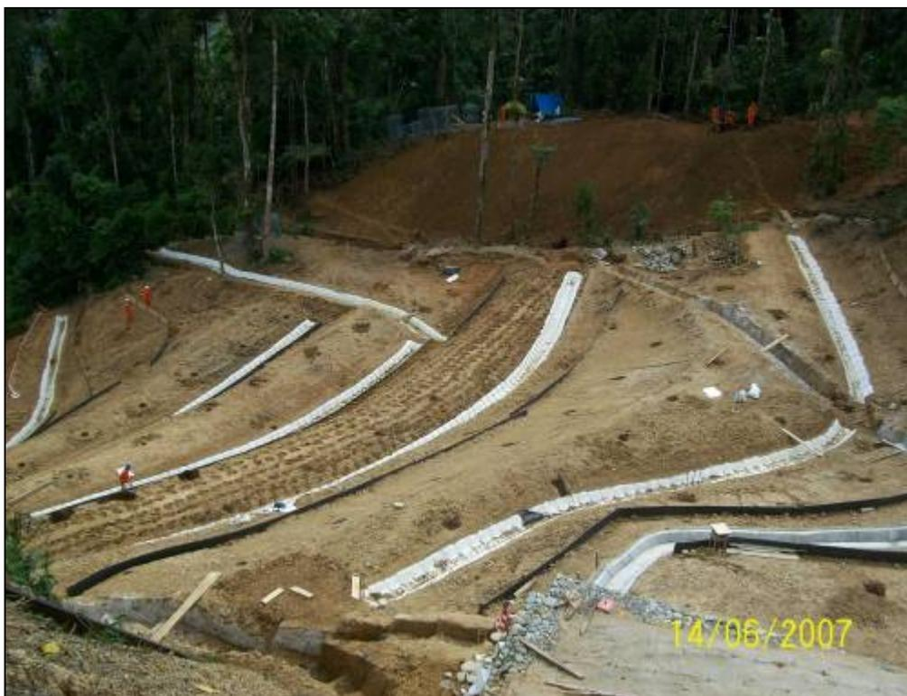
**Foto 4.** KP 108+150 lado Nor Oeste de la Estación PS2 -margen derecha del DDV - Vista Panorámica de obras de drenajes superficiales: canales de drenajes, canales colectores, y descoles.
