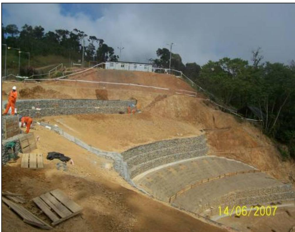
**Foto 3.** KP 108+150 lado Nor Oeste de la Estación PS2 -margen derecha del DDV - Vista Panorámica de gaviones de piedras en tres niveles de terraceo.
