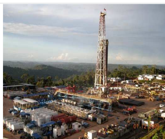
Plataforma Cashiriari 3: Vista de la plataforma de perforación en Cashiriari 3
