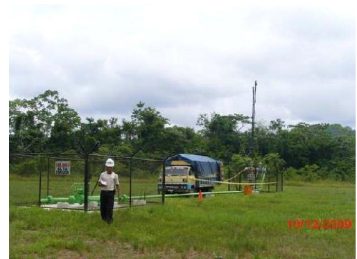
LOTE 31C: Trabajos de toma de registro en el Pozo 9. No se observa protección impermeable contra derrames
