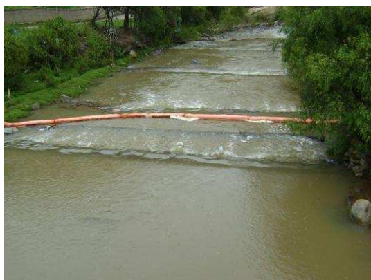
Cruce Río Yucay: Barreras geo-textiles para retener los sedimentos de las constructivas del cruce especial
