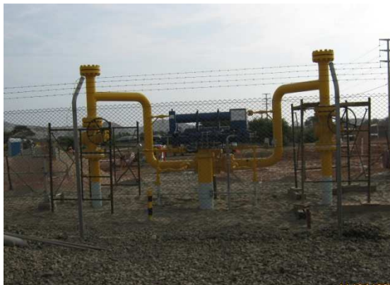
Válvula XV 21007, locación en construcción
