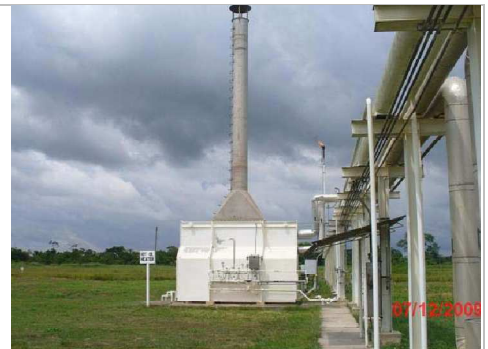
AGUAYTIA DEL PERU S.R.L: Columna de reflujo para la condensación del GLP, no cuenta con piso impermeable, ni alcantarillas.
