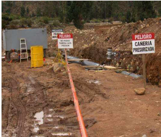
KP 113+100: Prueba hidrostática de sección 29B.
