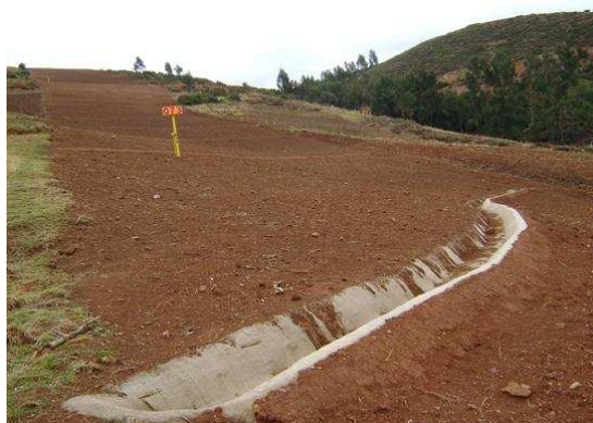
KP 73: DdV reemplazado y en proceso de bioremediación con surco contracorriente
