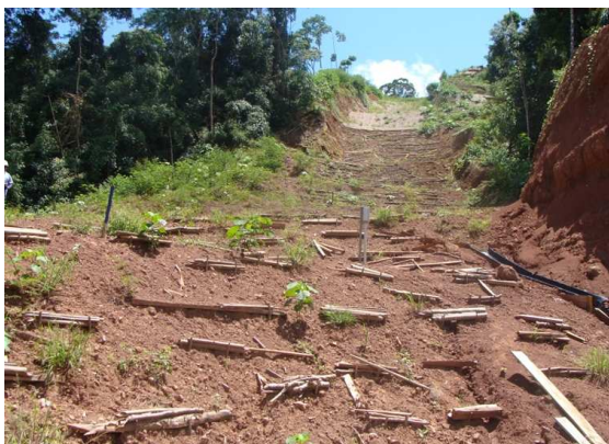
KP 45+200: Reconformación del DdV
