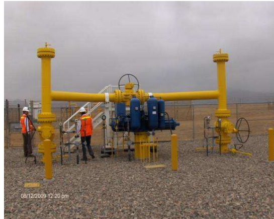
KP 393 (Válvula 14): Personal de ABS supervisando instalaciones.
