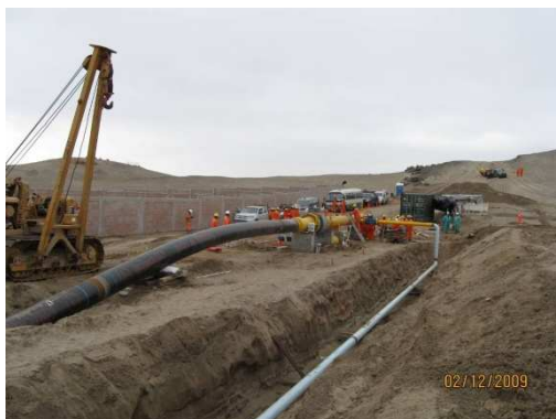
Trabajos de instalación de la cámara de recepción del Lopp Costa en el KP 699
