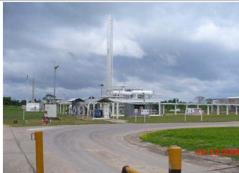
AGUAYTIA DEL PERU S.R.L: Vista de la Planta de Fraccionamiento de LGN en Yarinacochas.
