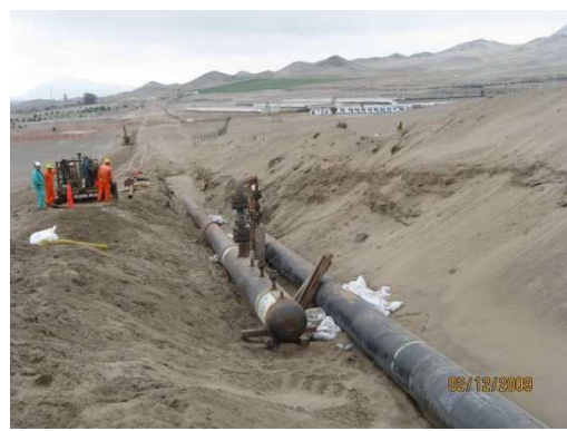
Prueba hidrostática del tramo KP 698 – KP 699 del Loop Costa
