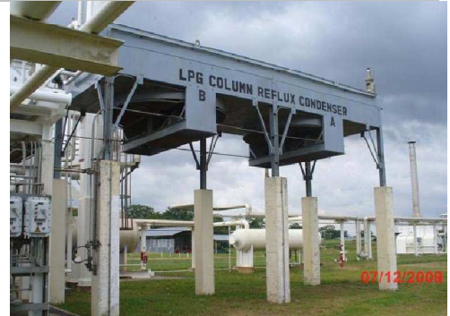
AGUAYTIA DEL PERU S.R.L: Columna de reflujo para la condensación del GLP, no cuenta con piso impermeable, ni alcantarillas.
