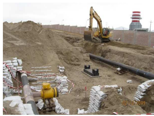
Válvula hot-tap en la línea de 18 pulgadas de TGP. Al frente de esta (de color negro) se observa la línea de 24 pulgadas (hot-tap).
