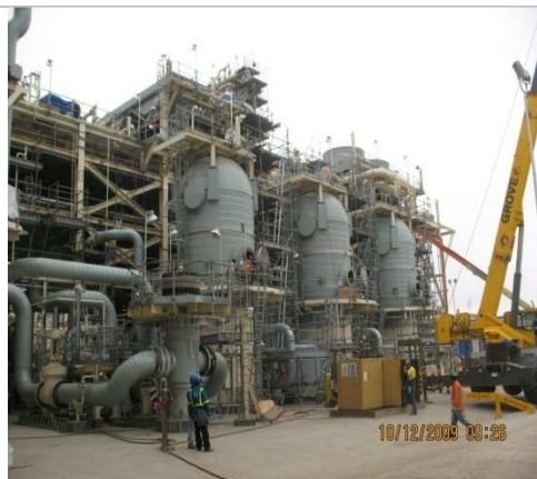
PLANTA MELCHORITA: Trabajos preliminares para la introducción del tamiz molecular en los deshidratadores
