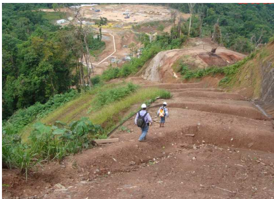
KP 33+200: Reconformado del DdV con corta corrientes altos.
