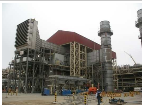
PLANTA MELCHORITA: Vista panorámica de turbocompresor de propano.
