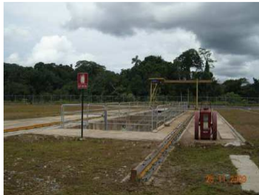
Plataforma Pagoreni A: Vista aérea de las instalaciones de producción en la plataforma de Pagoreni A, se observa con cerco perimétrico que cubre toda las instalaciones, dos torres de pararrayos para toda la plataforma de producción y se encuentra limpio y ordenado
