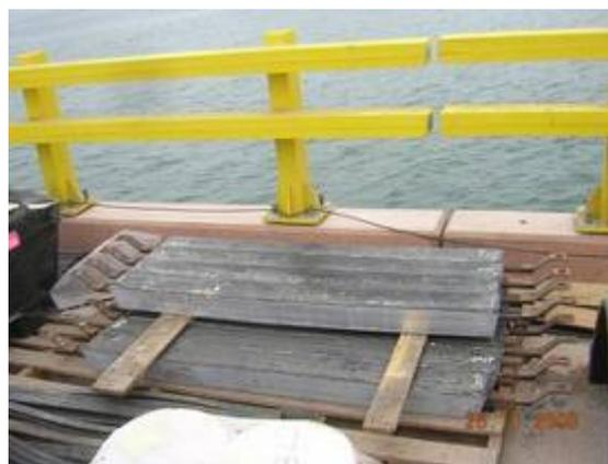
Ánodos de sacrificio que se instalarán para el sistema de protección catódica del Jetty
