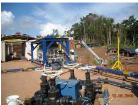
Plataforma Cashiriari 1 – Área de Proceso: (1) Separador Trifásico Horizontal de alta presión, (2) Floor Choke Manifold y (3) Líneas de flujo desde el Floor Choke Manifold hasta el Separador
