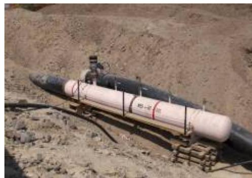
Kp 342+400, cabezal instalado en cercanías al río Pisco para la realización de la prueba hidrostática
