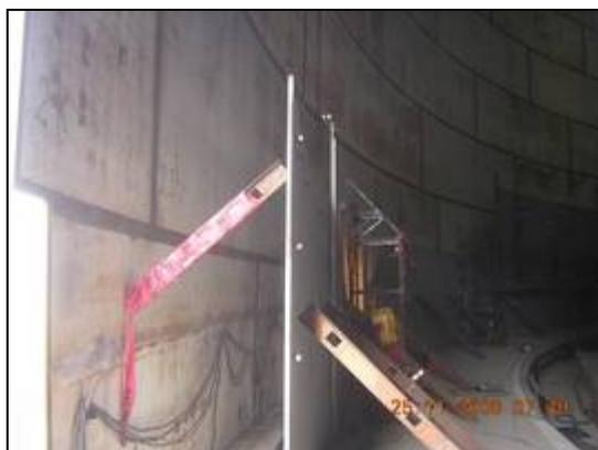
TQ 3401. Sistema de sujeción del primer anillo del tanque interno, sobre el tanque externo y el fondo
