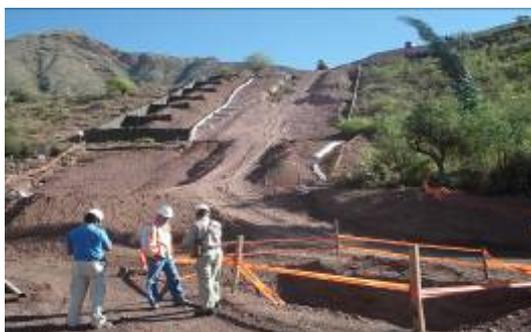
KP 41; Tubería en este tramo está soldada y parcialmente enterrada. Los trabajos de geotecnia consisten en instalación de tapones de poliuretano dentro de zanja
