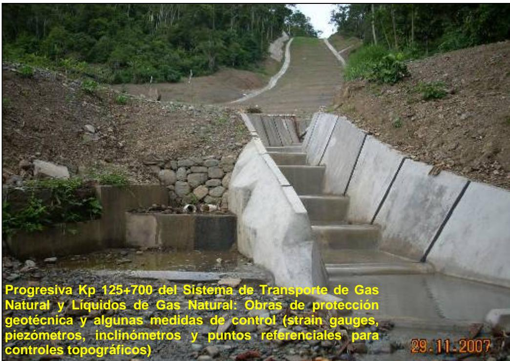
Progresiva Kp 125+700 del Sistema de Transporte de Gas Natural y Líquidos de Gas Natural: Obras de protección geotécnica y algunas medidas de control (strain gauges, piezómetros, inclinómetros y puntos referenciales para controles topográficos)
