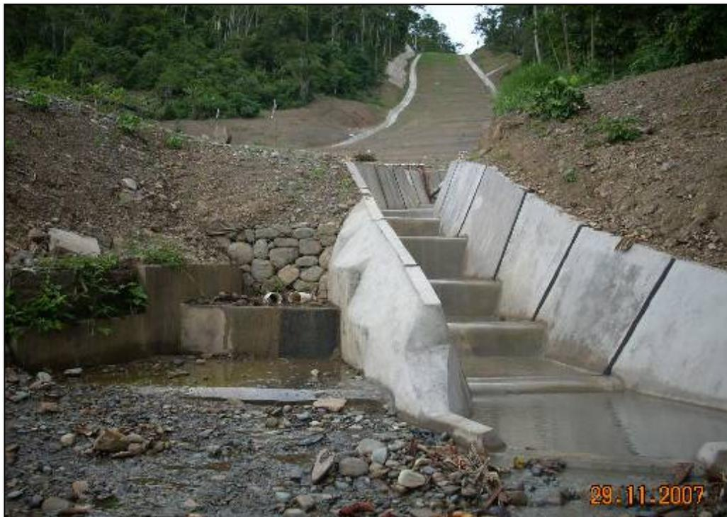
**Foto 1.** Selva. Se verificaron las obras de protección geotécnica y algunas medidas de control (*strain gauges*, piezómetros, inclinómetros y puntos referenciales para controles topográficos), a propósito de la temporada de lluvias. La foto corresponde a una trinchera drenante en el KP 125+700, margen derecha.
