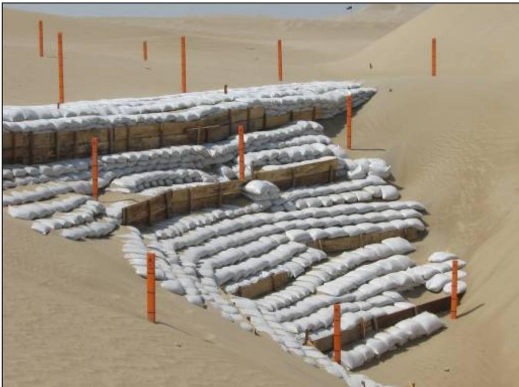
**Foto 10.** Vista de cerca de los trabajos de contención y ensacado en el Kp 530 para prevenir que los vientos continúen profundizando el destapado de la tubería
