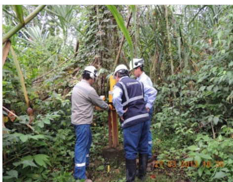
Vista de medición de potenciales de protección catódica en KP 00+160.
