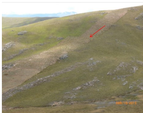
KP 81+500 Vista del DdV emplazado en suelos morrénicos estables atravesando una altiplanicie con topografía moderada.
