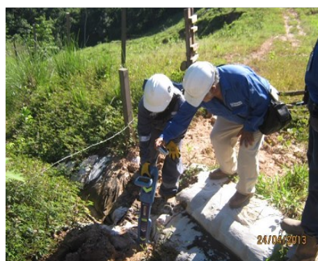
KP 25+880: Vista de la verificación del cumplimiento del tema "Control contra la Corrosión" de la DJ de Criticidad Moderada de Enero 2013 (Ducto LGN)
