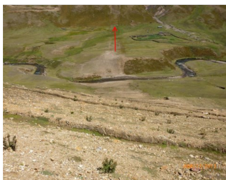
KP 178+500 Vista panorámica del DdV en el cruce con el río Palmitos donde se evidencia la estabilidad del tramo y los cortacorrientes descolmatados.
