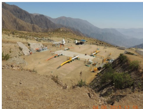
Vista panorámica de la PRS2. Color amarillo para ducto de GN y color naranja para poliducto de LGN.
