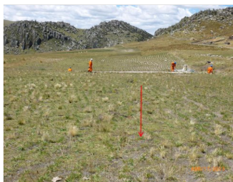
KP 127+500 Vista panorámica del DdV emplazado en terreno estable y plano donde se observa una cuadrilla de mantenimiento de Perú LNG.
