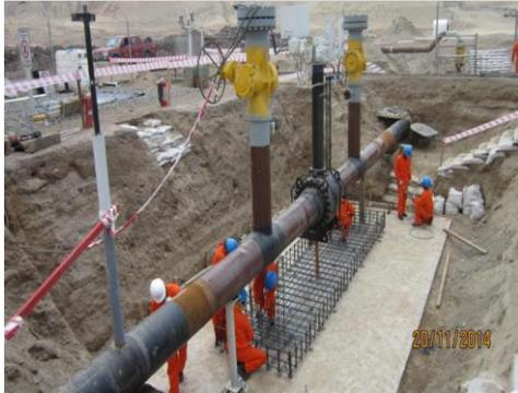
Vista de la construcción de la malla para el encofrado de la caja de hormigón que protegerá la válvula XV-10021.
