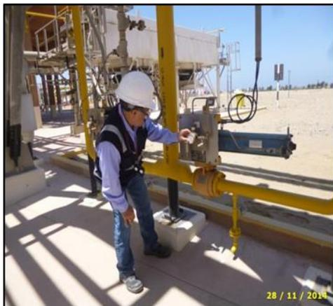
Personal de Osinergmin verificando las condiciones de operación de la ESDV-15002 que corta el gas combustible al Horno de Nafta en la Planta N° 2, en casos de emergencia. Esta válvula fue sometida a mantenimiento y pruebas el 28.10.2014, verificándose la operación de la válvula llevándola a su posición totalmente cerrada y abierta desde la Sala de Control.
