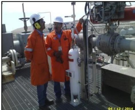
Supervisores de Osinergmin observando a la PVR-114603, la misma que libera una sobrepresión del aire de instrumentación aplicada a la válvula hacia el tanque de Blowdown BDV-114009. En el año 2014 Perú LNG cumplió con el programa de inspección y calibración de las PRV's.
