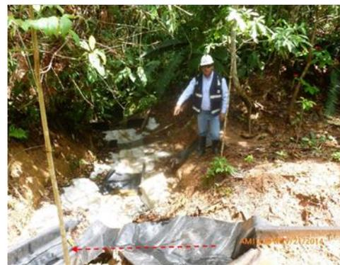
KP 18+520: Vista de la verificación de la reparación y mejoramiento de canal de evacuación de las aguas de escorrentía superficial fuera del DDV. Tramo estable.
