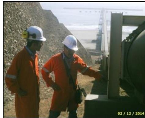
Personal de Osinergmin observando el desplazamiento de las tuberías de embarque de GNL (rundown), con relación a los soportes de concreto, las mismas que están protegidas con una abrazadera metálica que absorben los movimientos que sufren durante las operaciones de embarque y retorno desde el Jetty (ver al fondo). Este desplazamiento del orden de centímetros es monitoreado y corregido por personal de inspección y mantenimiento de la Planta Melchorita.
