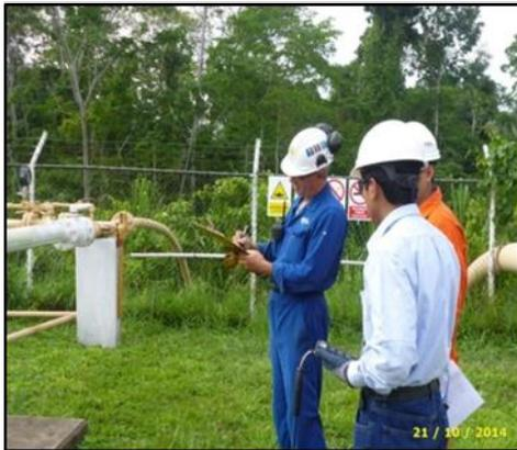
Durante recorrido por planta, se observó trabajos de inyección de un "chanchito" de limpieza en la tubería de líquidos de gas natural (condensados) de 4" de diámetro. Se comprobó que para el trabajo, se realizó la elaboración del Permiso de Trabajo en el sitio mismo, con monitoreo de gases con el adecuado Exposímetro.
