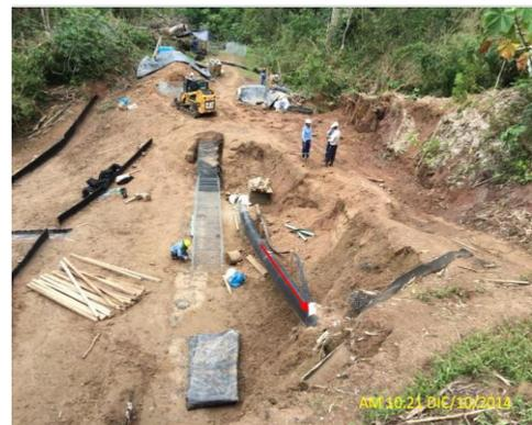
KP 2+630: Vista panorámica del área deslizada del talud inferior en el lado izquierdo del DdV, el cual ocasiono la exposición de la tubería en una longitud de 16.5 m.
