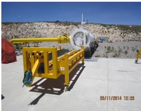
Vista donde se aprecia al Scraper de recepción SR - 032, ubicada a 4700 m.s.n.m. Se aprecia asimismo la “cuna” adquirida por Perú LNG para actividades de extracción de raspabubos.
