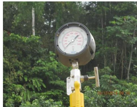
Vista cercana del manómetro de lectura directa instalado sobre la Scraper de lanzamiento de Kinteroni el cual indica 0 psi de presión interna.
