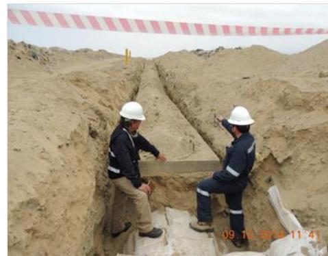
KP 379: Vista del avance de la instalación de las losas de concreto de protección del ducto de PLNG, en el punto de inicio.
