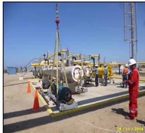
Actividades previas para el lanzamiento del “chancho inteligente” en las tuberías submarinas de propano y butano, para realizar un ILI (inspección del interior de las tuberías). Antes las tuberías fueron limpiadas con el “chancho” de limpieza
