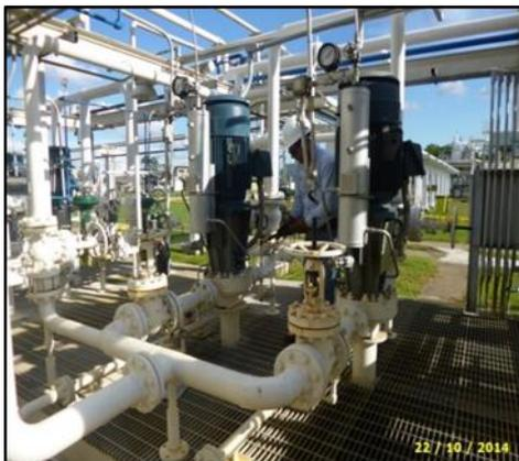
Durante recorrido por Planta, se verificó que personal de mantenimiento efectuaba monitoreo de gases con Exposímetro, en una de las electrobombas de alimentación de líquidos a la fraccionadora, la misma que sería sometidas a mantenimiento eléctrico.
