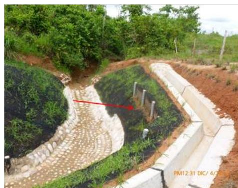
KP 9+100: Recuperación de tapada de las tuberías de GN y LGN en el cauce de quebrada mediante canal de mampostería de piedras y cemento.
