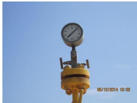
Vista cercana del manómetro instalado sobre la cámara de lanzamiento R-2001 el cual indica una presión interna de 116 bares.
