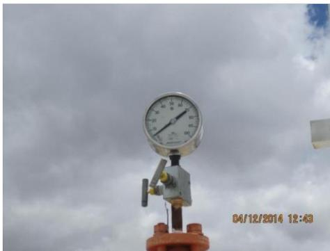
Vista cercana del manómetro de lectura directa instalado sobre la cámara de recepción R-5701, el cual indica 04 bares de presión interna.
