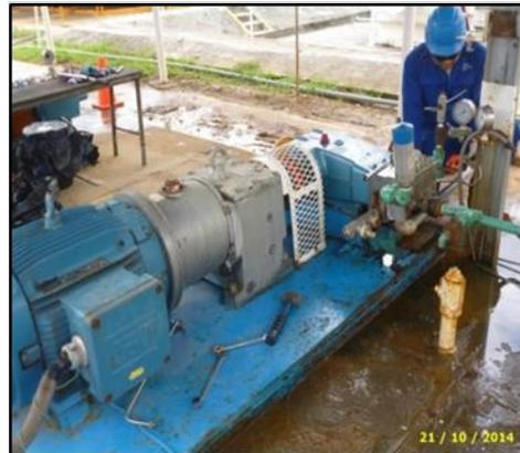
Durante el recorrido de planta, se realizaba trabajos de mantenimiento a una de las bombas de recuperación de líquidos, la misma que cuenta con guarda de seguridad en sus partes móviles, al igual que todos los equipos rotativos existentes en la planta.
