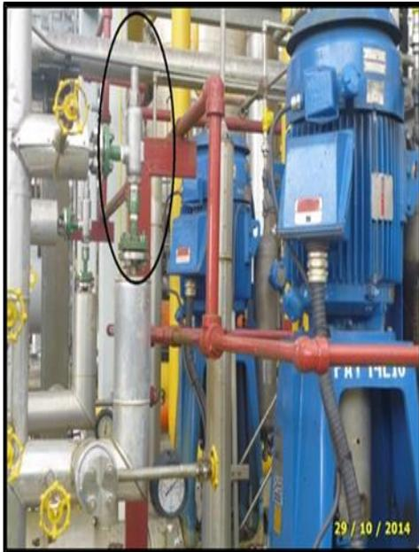
Se verificaron el estado de las PSV's de la Planta. La vista muestra a la válvula PSV-14210 ubicada en la descarga de la bomba PAY-1420 del reflujo a la deetanizadora de la unidad criogénica N° 3, inspeccionada y calibrada anualmente al igual que todas las demás PSV's existentes en Planta.
