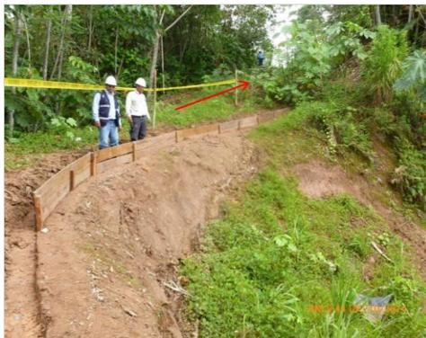
KP 2+350: Vista de supervisor de OSINERGMIN verificando los trabajos de control de erosión en la corona de talud inferior del DdV.
