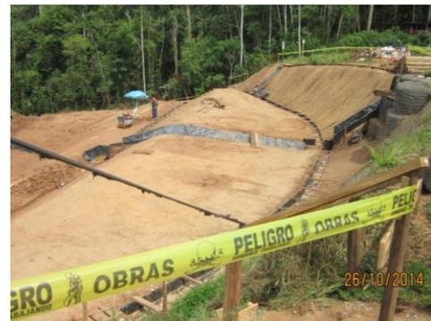
KP 17+600: Vista de los trabajos de reparación y afianzamiento del talud.
