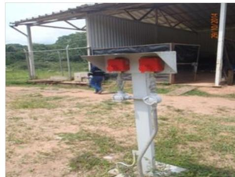
Kinteroni: Shut Down nivel 3 y 4, botonera de accionamiento para el cierre de los pozos de acuerdo al nivel, nivel 3 cierre del pozo y de todos los componentes, nivel 4 cierre de los pozos y todos los componentes con flujo hacia el flare.
