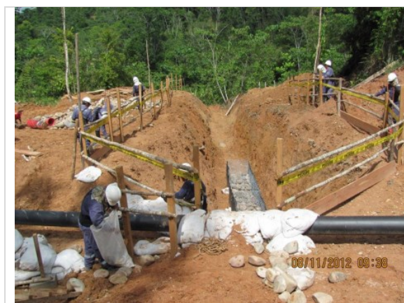
Vista de los trabajos de instalación de un gavión dentro de una zanja ubicada perpendicularmente al trayecto del ducto de 10\".
