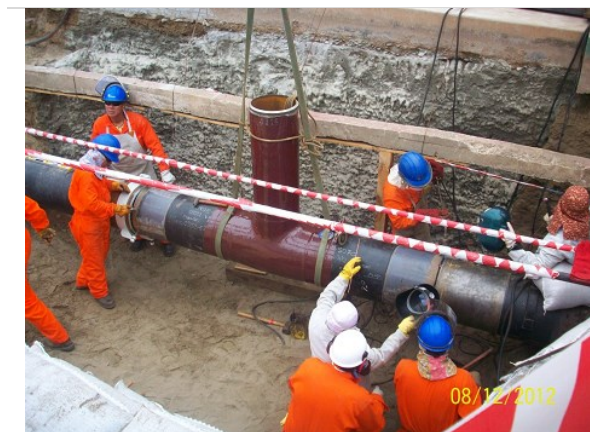
Vista de instalación de una T de derivación para conectar la salida del nuevo filtro separador F-2201D - TIE IN-002
