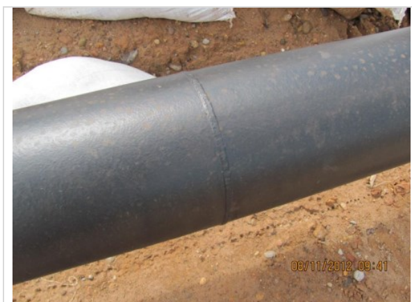
Vista cercana de la superficie de tubería de 10\" con aplicación de pintura epoxi-coaltar.
