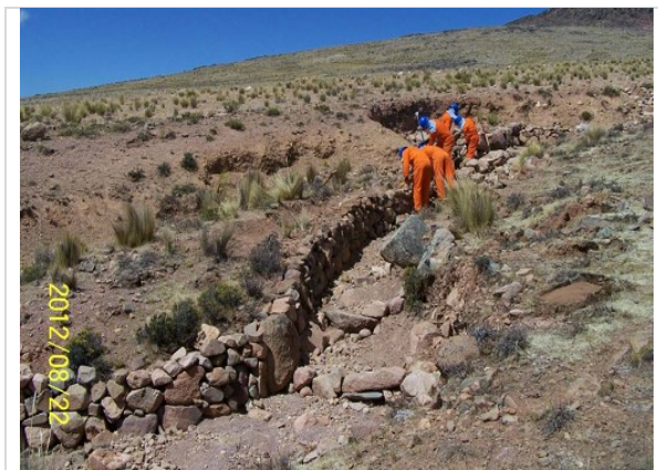
KP-435+900 Trabajos de reconstrucción y reforzamiento de los canales naturales que cruzan el DdV de TGP.
