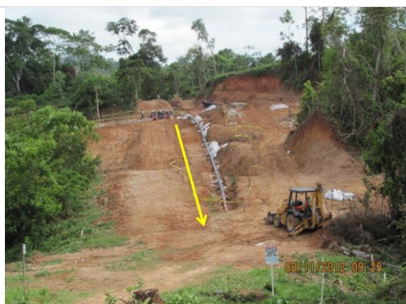
Vista panorámica de alrededores del KP 67+050. Se aprecia el tramo de tubería instalada.
