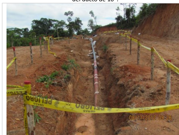
Vista parcial del nuevo tramo de tubería de 10\" instalada.
