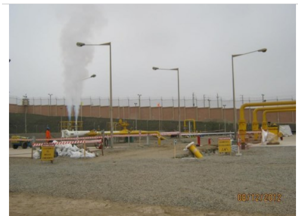
Despresurización Total del City Gate Lurín luego de las maniobras de barrido/purgado y puesta en servicio de bypass temporal de 14"
