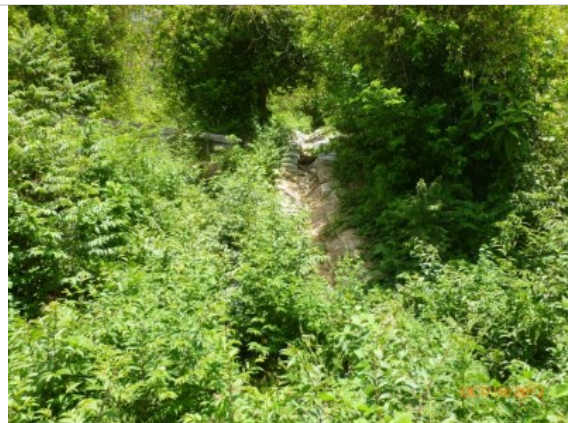
KP 36+928 Obras de control de erosión y de drenaje cubiertos con vegetación (Zona estable al momento de la supervisión).
