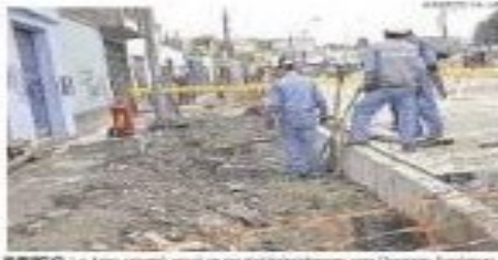
El hecho se produjo cuando los obreros de la contratista Consorcio Vial Colonial realizaban trabajos de empotrado del sardinero.
