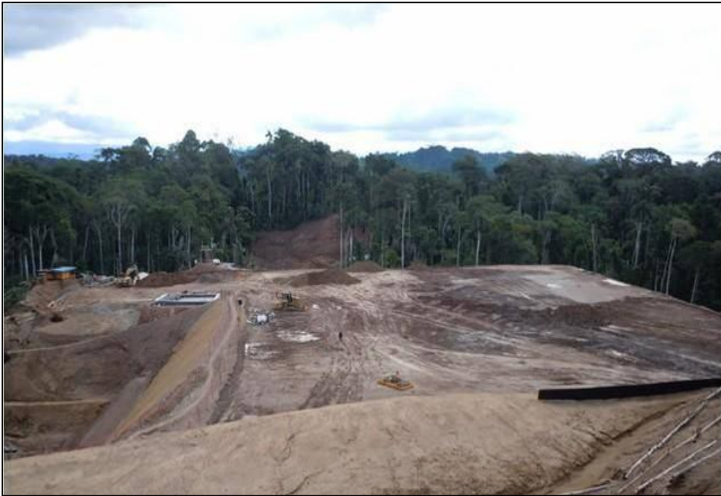
Vista de la construcción de la plataforma
