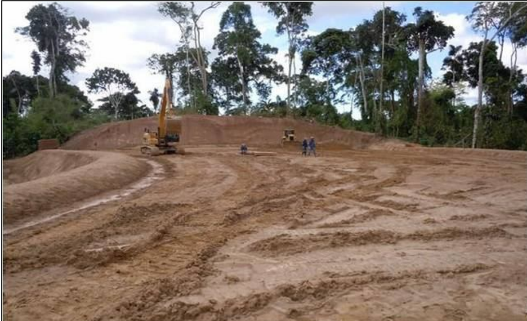
Vista de los trabajos realizados
